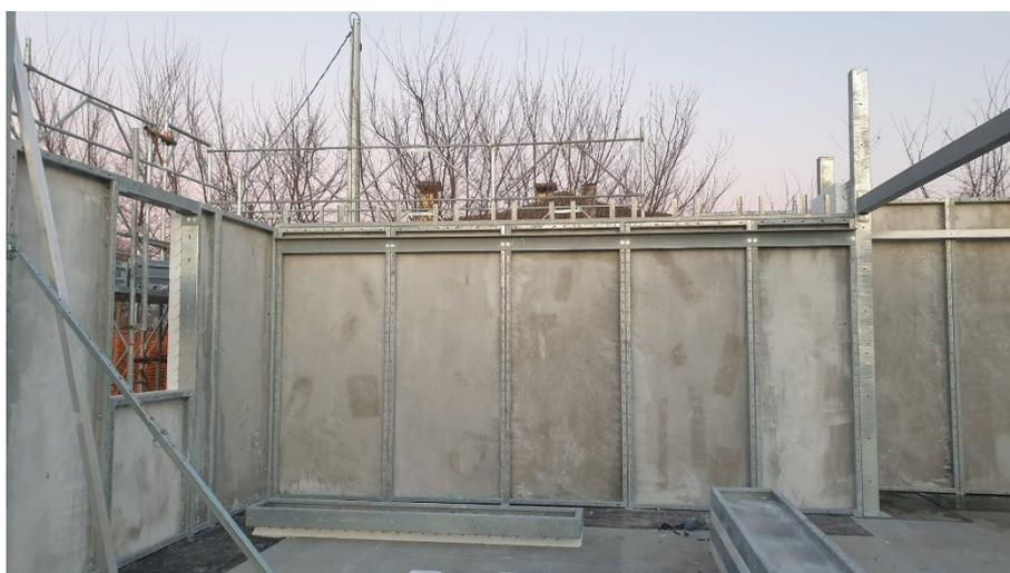
▼ Angolare di appoggio travi solaio
